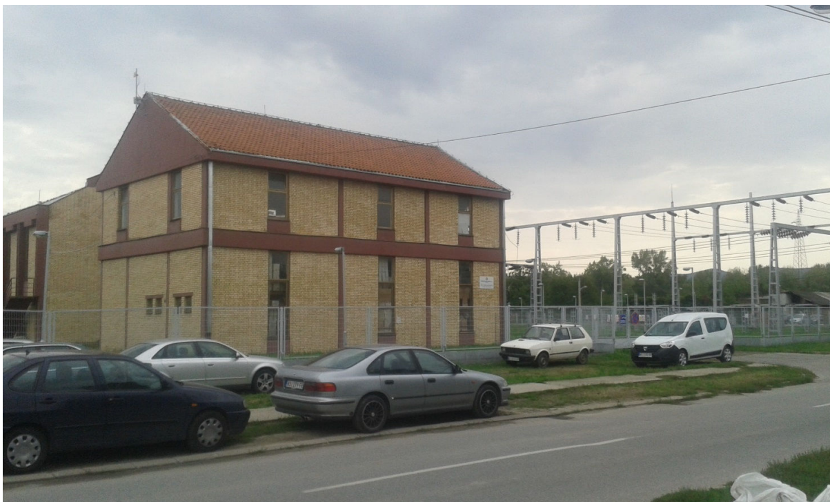
Слика V- ТС 2.1 Изглед трансформаторске станице
