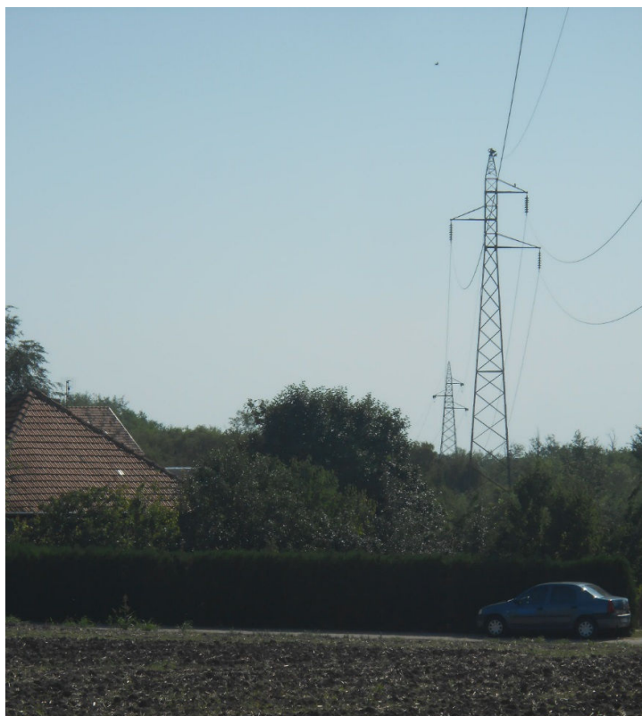
Слика V- НВ 2.1 Изглед надземног вода
