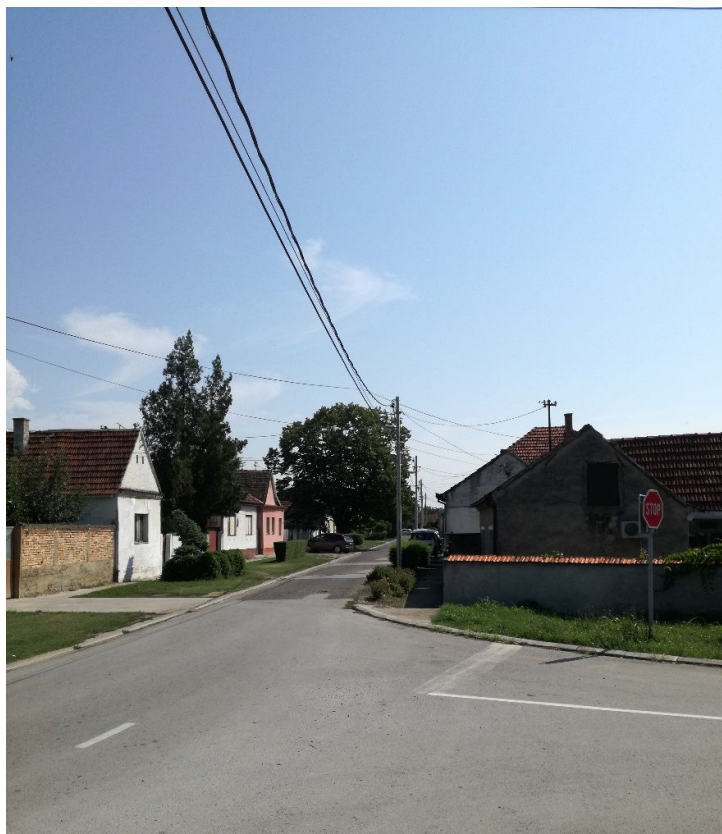
Слика V- НВ 2.1 Изглед надземног вода
