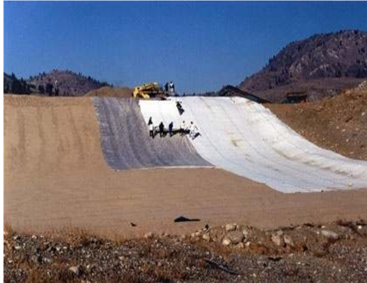
Слика 22. Постављања доње непрпусне фолије.
