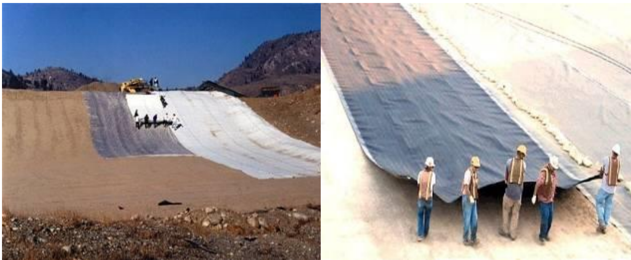
Slika 5.16. Postavljanje donje nepropusne folije.
