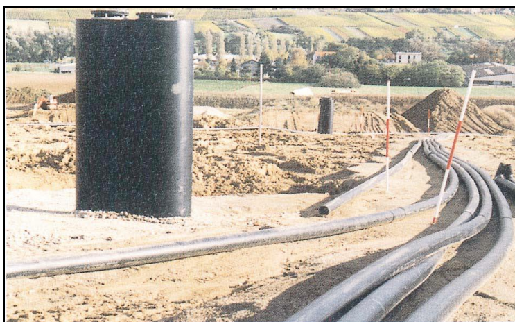
Slika 4.16. Primer sistema za sakupljanje gasa
