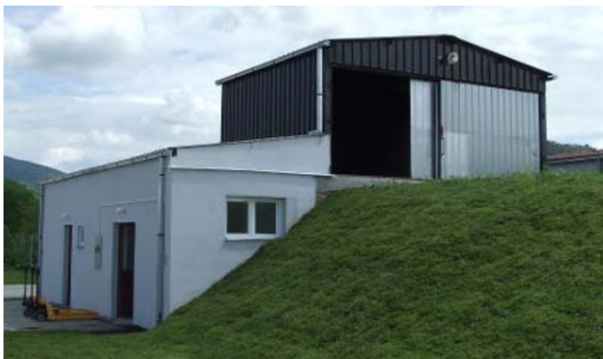
Слика 48 - Сабирни пункт (хладњача) за привремено складиштење кланичког отпада у Вршцу
