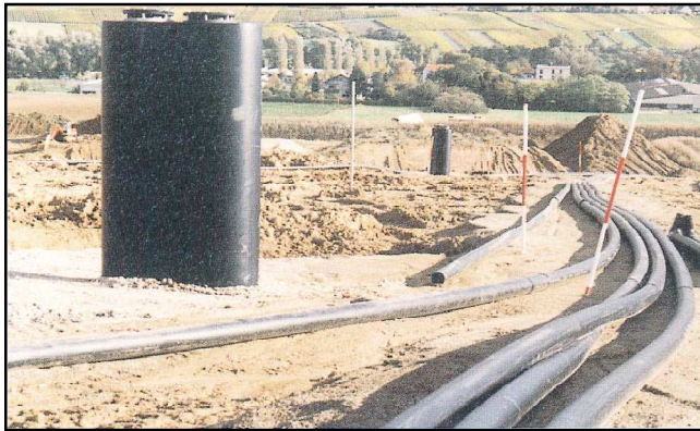
Слика 4.16: Пример система за сакупљање гаса
