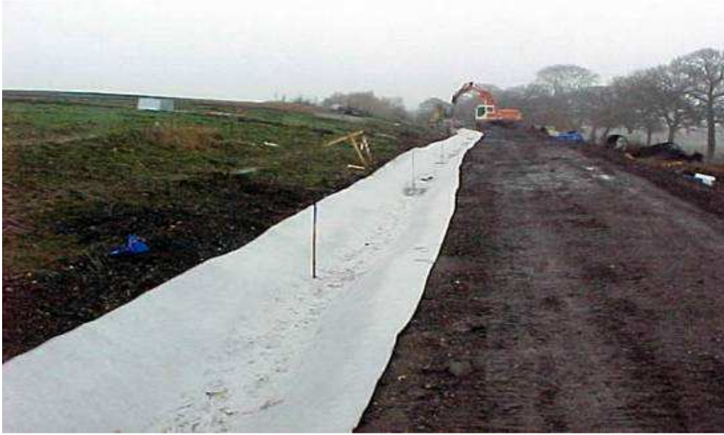
Слика 5.14: Приказ депоније са ободним каналима за отицање воде са фолије
