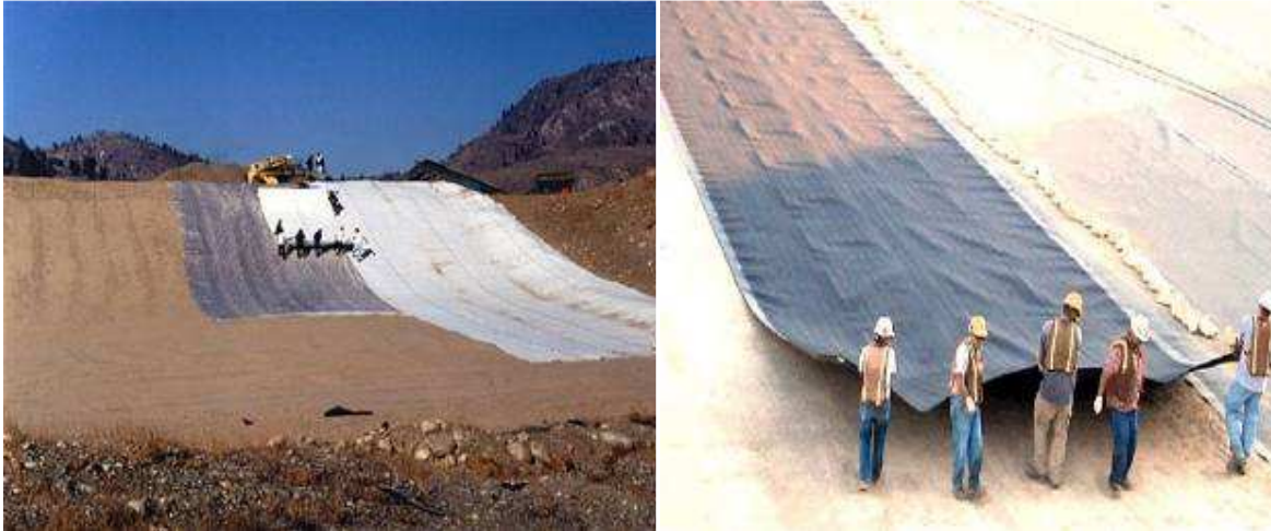
Слика 5.16: Постављања доње непрпусне фолије.
