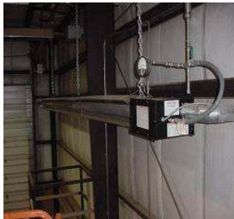
Слика 4.17: Инфрацрвено грејање просторија
