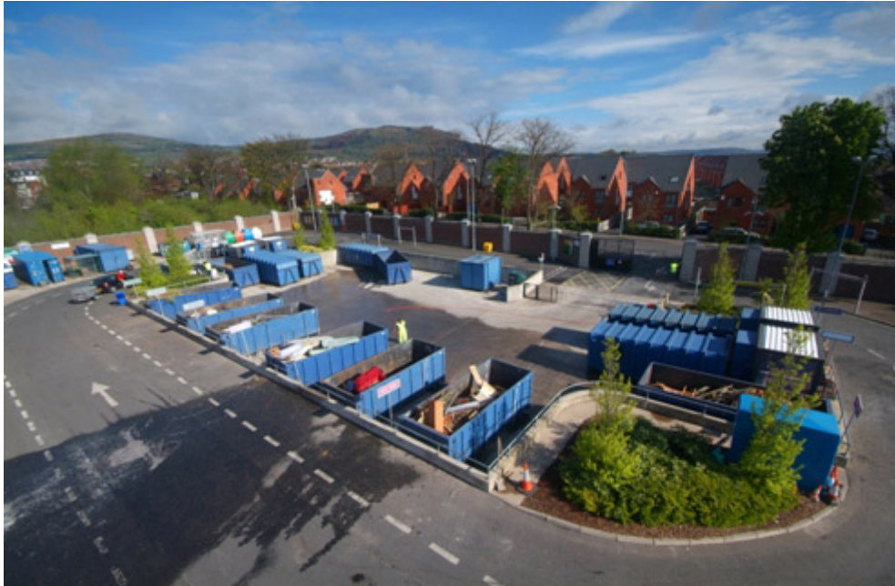
Слика 6.8. Изглед једног рециклажног дворишта
