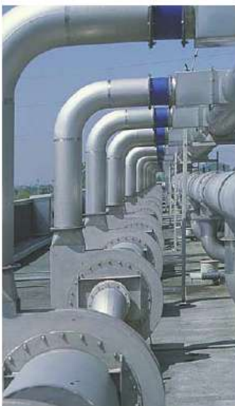
Ventilatori za kontrolu vazduha
