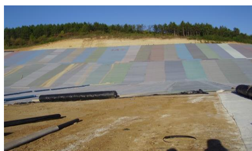
Слика 5. Санитарна депоније "Жељковац" у току изградње
