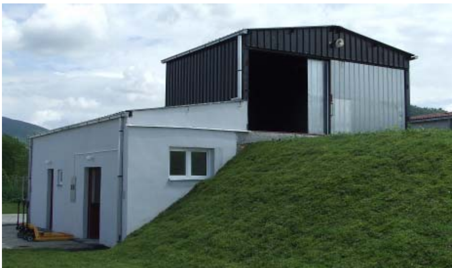
Слика 54 - Сабирни пункт (хладњача) за привремено складиштење кланичког отпада - пример у Вршцу
