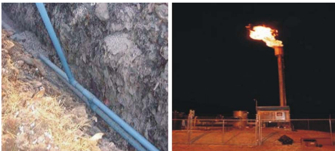
Слика 2 - Систем сакупљања и сагоревања депонијског гаса
