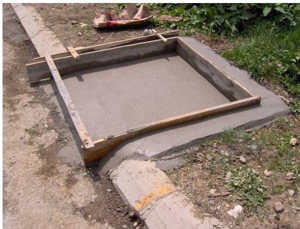
Слика 12. Бетонски плато за металне контејнере
