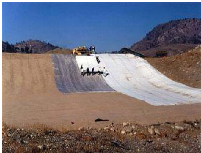
5.21. kép: Az alsó át nem eresztő réteg elhelyezése
