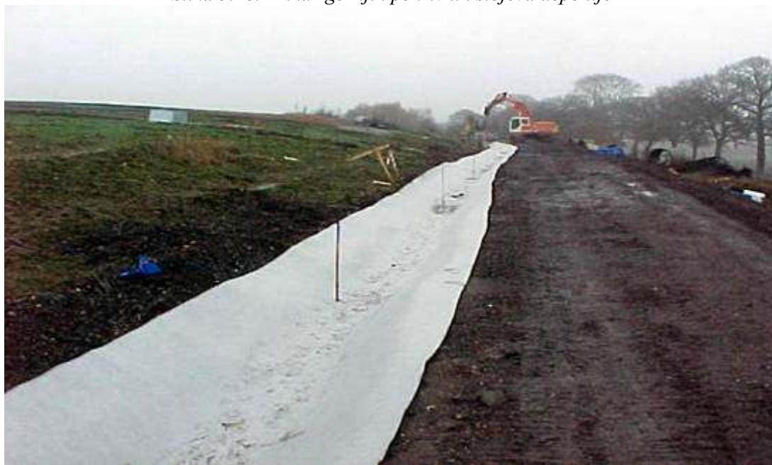
Slika 5.19. Prikaz deponije sa obodnim kanalima za oticanje vode sa folije
