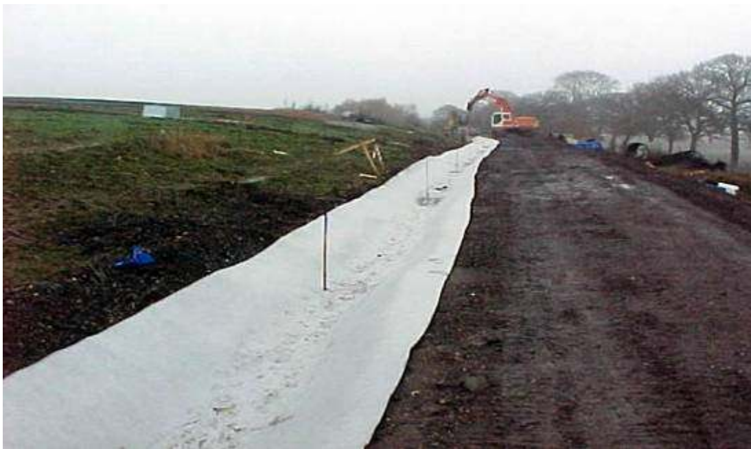
5.19. kép: Hulladéklerakó bemutatása perifériás csatornákkal a víz elvezetésére a fóliáról
