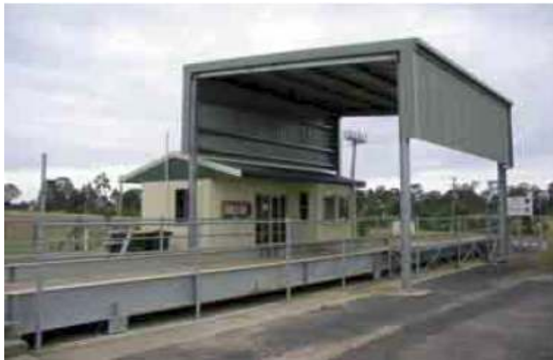
5.15. kép: Mérleg a transzferállomáson
