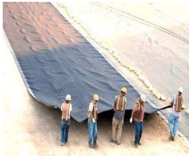
5.21. kép: Az alsó át nem eresztő réteg elhelyezése
