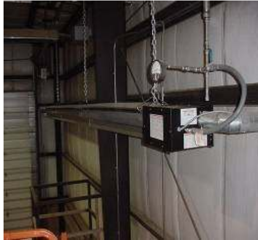
6.18. kép: A helyiség infravörös fűtése
