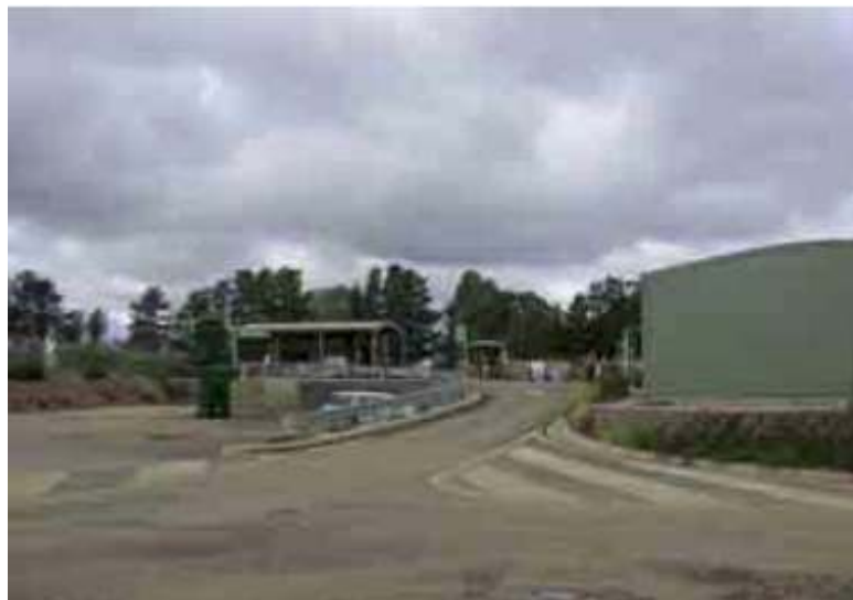
Slika 5.16. Izgled transfer stanice
