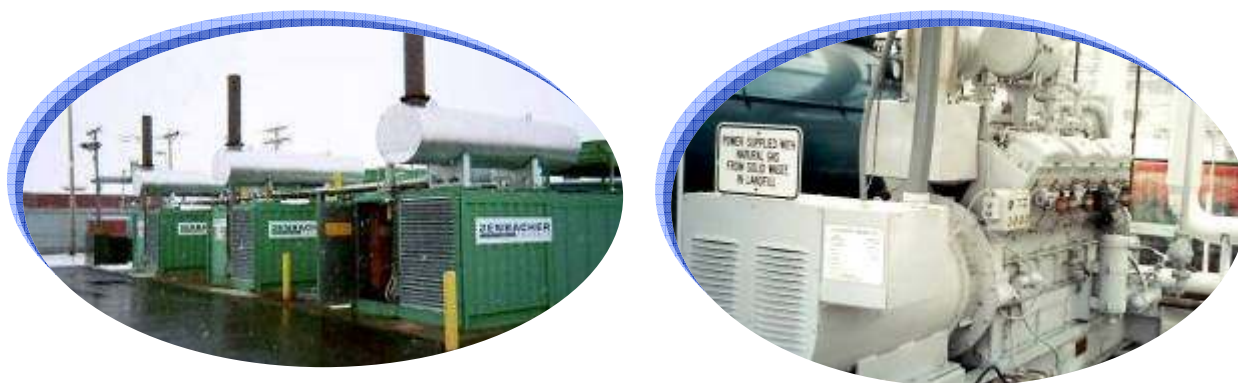
Slika 6.19 Sagorevanje deponijskog gasa
