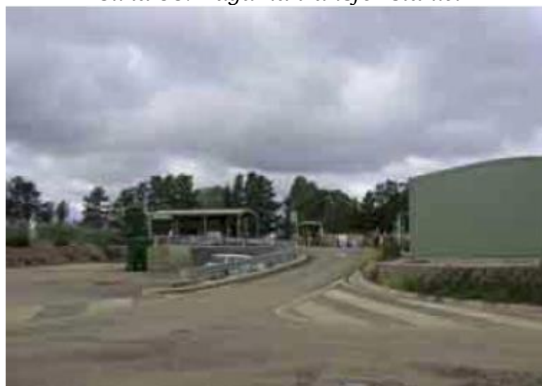
Slika 36. Izgled transfer stanice
