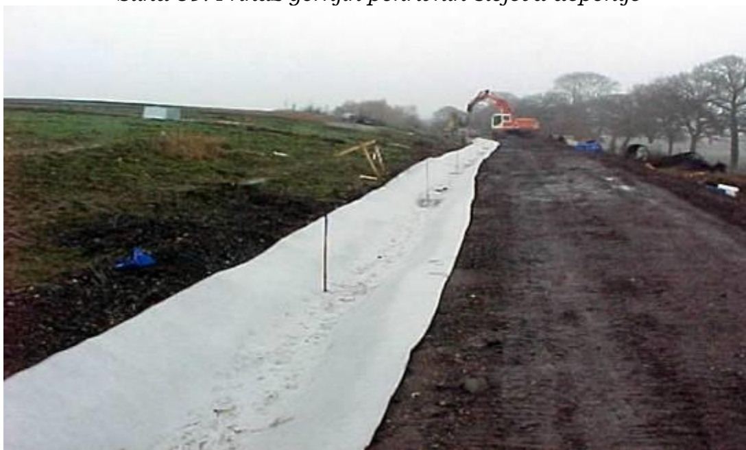
Slika 40. Prikaz deponije sa obodnim kanalima za oticanje vode sa folije
