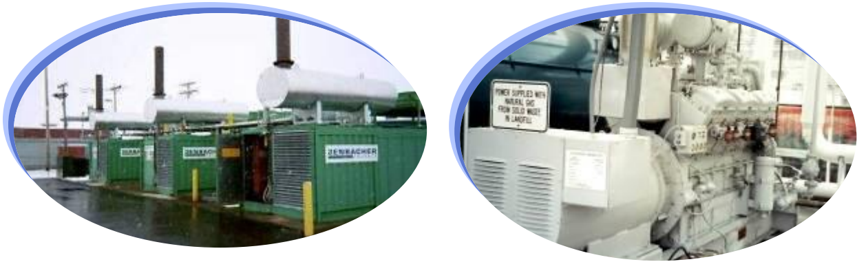
Slika 21. Sagorevanje deponijskog gasa
