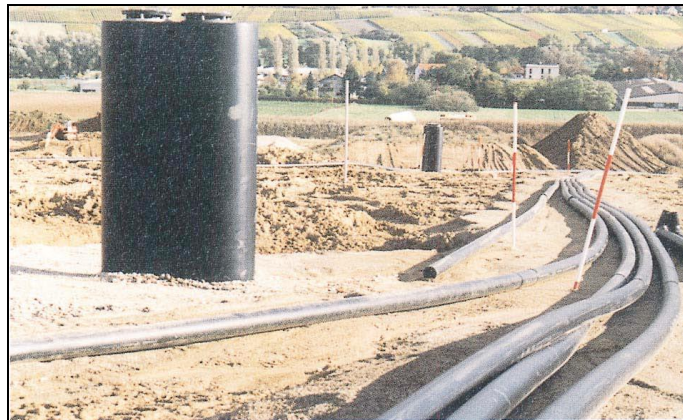
Slika 19. Primer sistema za sakupljanje gasa
