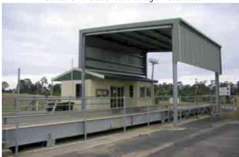
Slika 35. Vaga na transfer stanici
