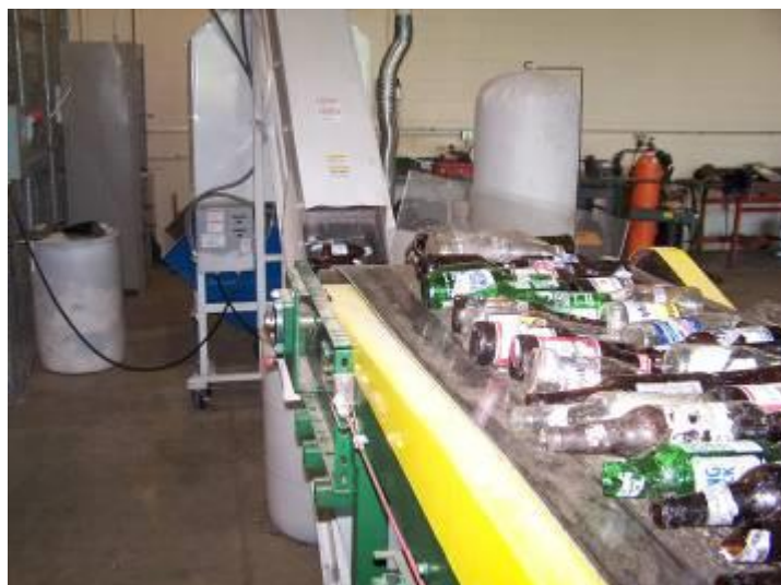
Slika 9 Postrojenje za reciklažu stakla
